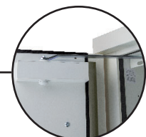
Ferme-porte avec thermofusible
