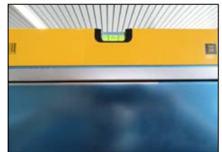
Ill. 12 Alignement à l'aide d'un niveau
