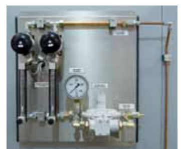
Système d'alimentation en gaz pour HFL 160/17
